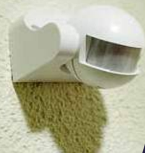
Освещение подъездов с датчиками движения
